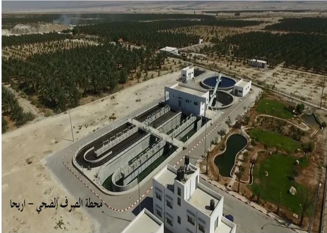
صورة 2.4 محطة معالجة أريحا (بلدية أريحا)
