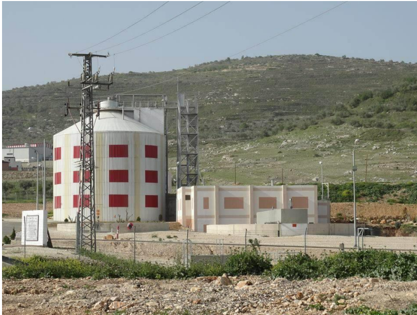
صورة 2.3 محطة معالجة نابلس الغربية (بلدية نابلس)
